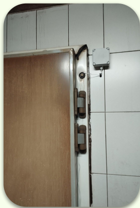
HLADNJAČA GOTOVIH PROIZVODA
